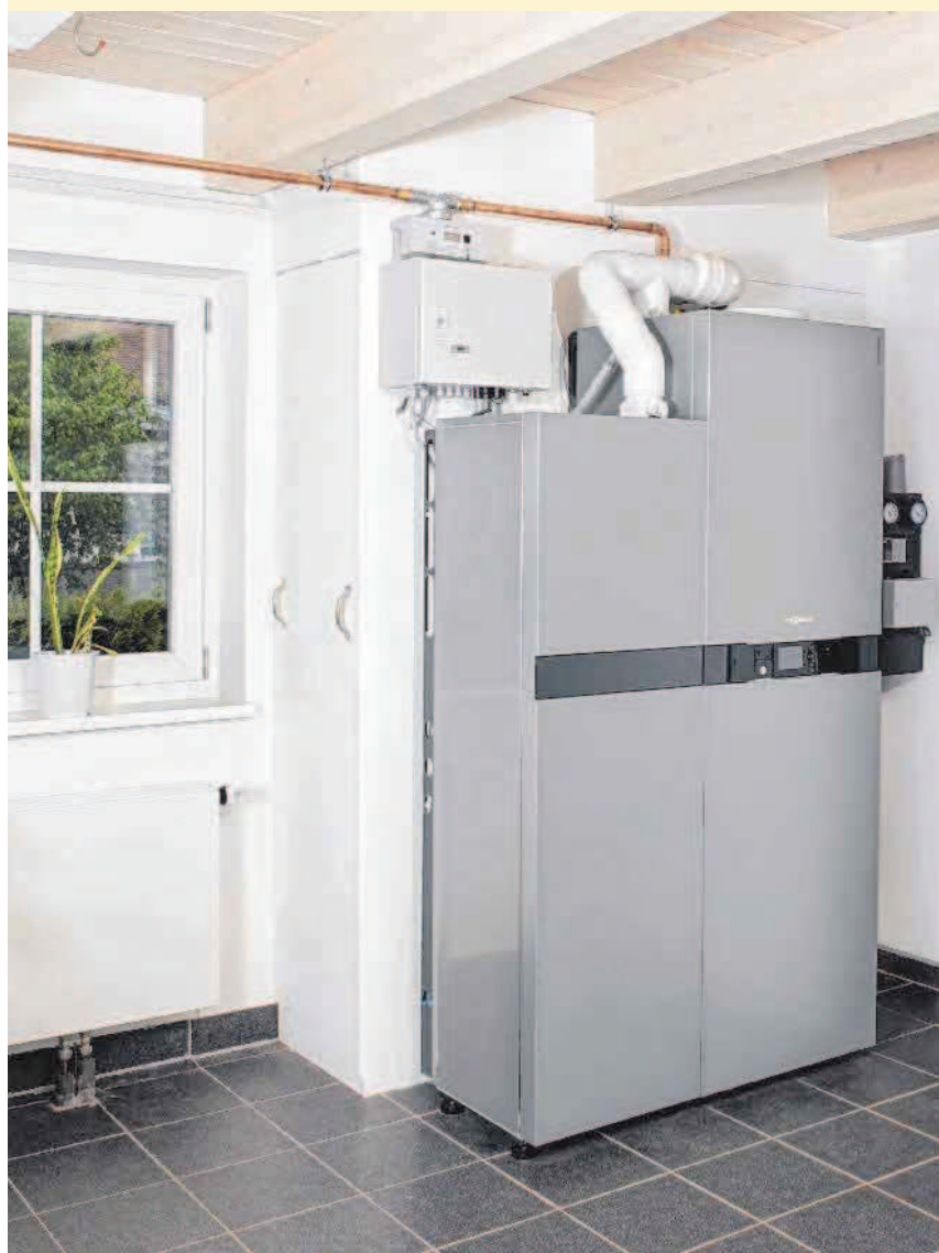
Der Vitocal von Viessmann wird von Miehle & Noak eingebaut.
